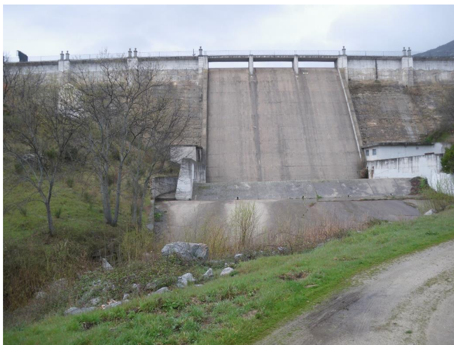
Foto 8.- Presa del Batán, en el arroyo del mismo nombre.
