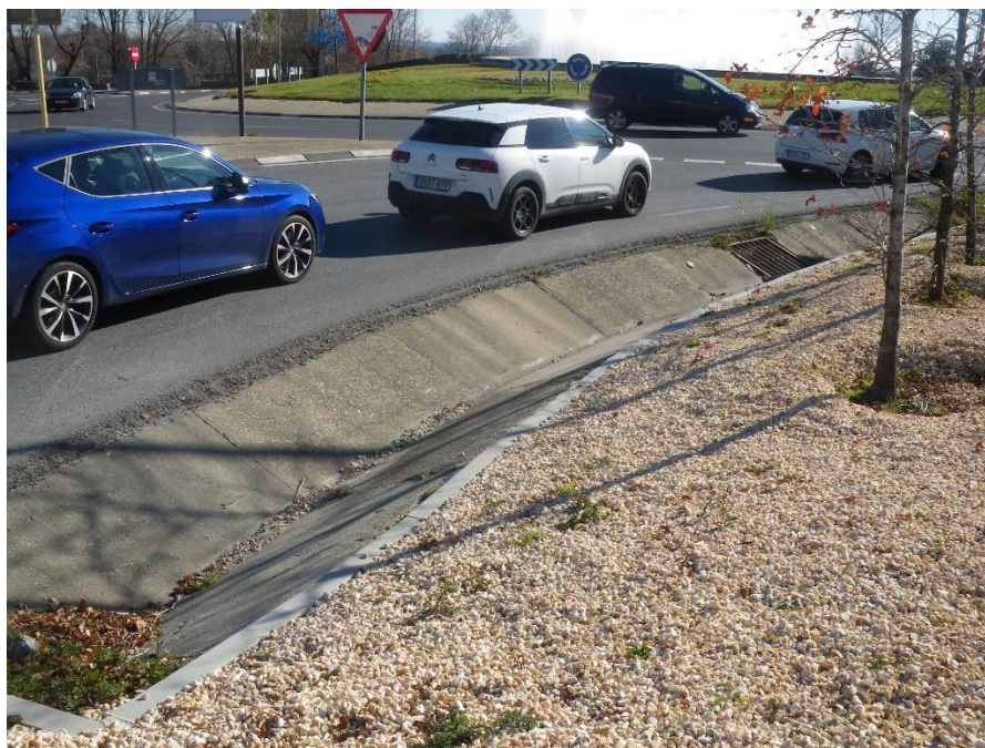
Foto 2.- Zona inundable en la rotonda de la M-600 con calle las Pozas, por acumulación de agua procedente de esta calle.
