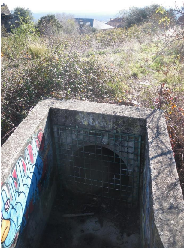
Foto 3.- Inicio del soterramiento del arroyo de las Cebadillas.
