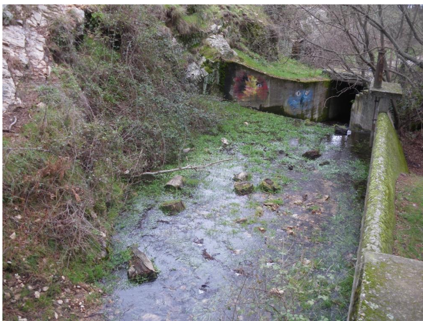
Foto 6.- Inicio del trasvase soterrado del arroyo de la Barranquilla.
