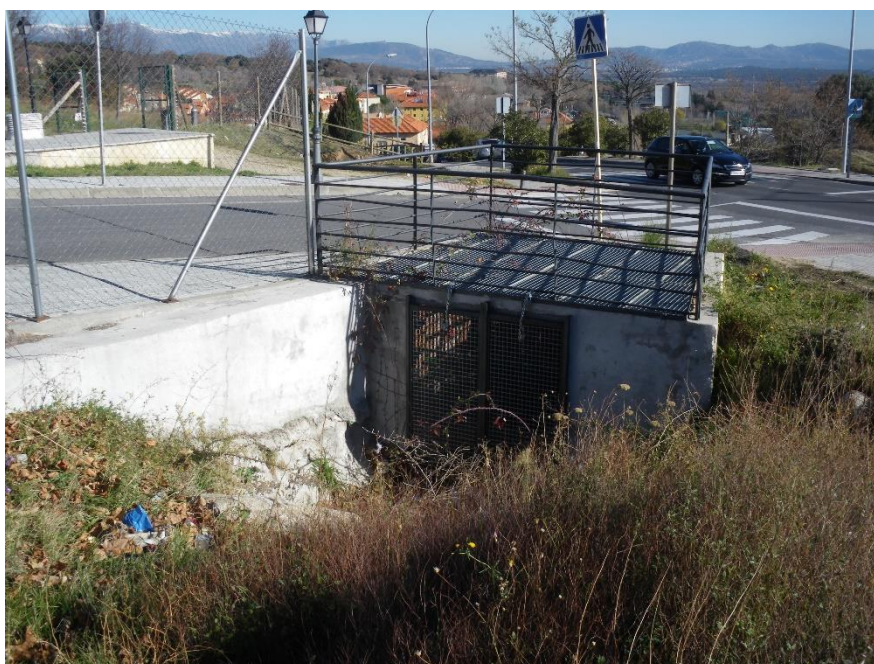
Foto 4.- Las aguas que no entran al soterramiento son captadas en un pozo existente en la esquina entre las calles Juan de Villanueva y las Pozas.
