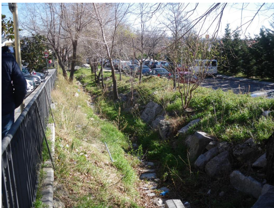
Foto 7.- Encauzamiento del arroyo de las Cebadillas a lo largo de la calle las Pozas.
